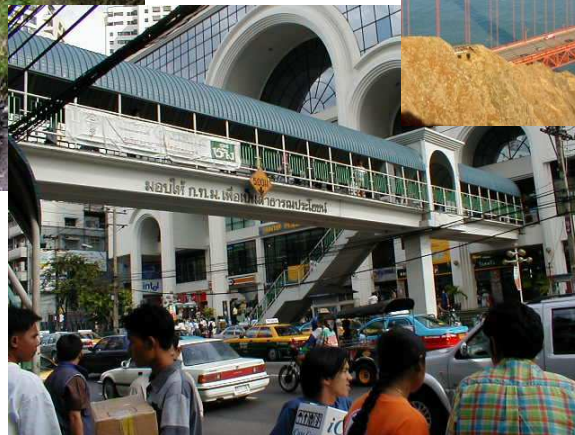
Un pont pour piétons en centre ville
