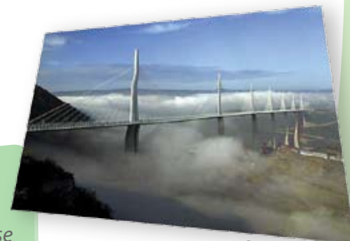
Pont de Millau
