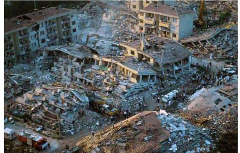
*Effondrement en «mille-feuille». Les poteaux ont cédé sous l'effet de la secousse et les planchers se sont effondrés les uns sur les autres*
