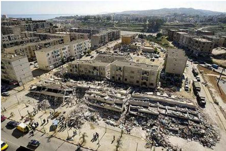
*Ici les bâtiments à structure de type Voiles-Planchers semblent avoir mieux résisté que les bâtiments à structure Poteaux-Planchers*
