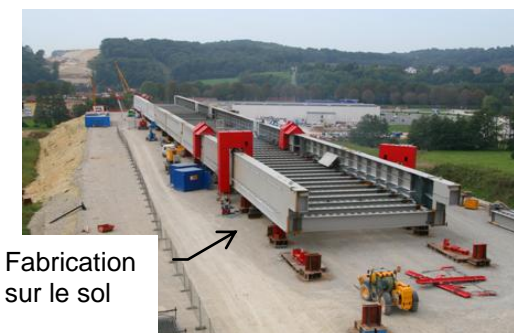
Zone de liaison des travées par soudure
