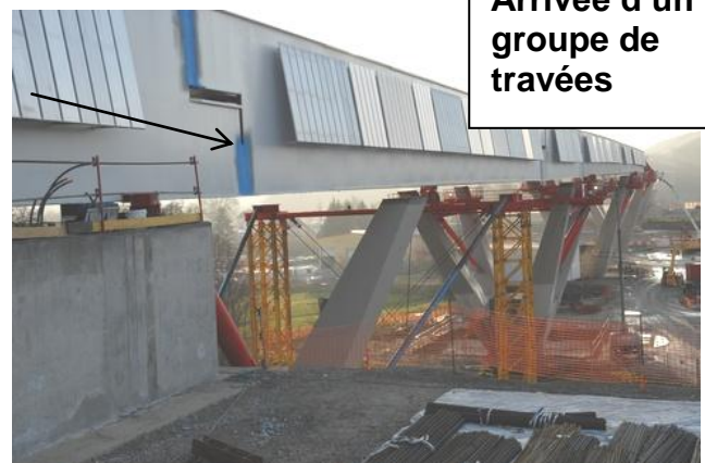
Zone de liaison des travées par soudure
