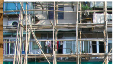
échafaudage en bambou
